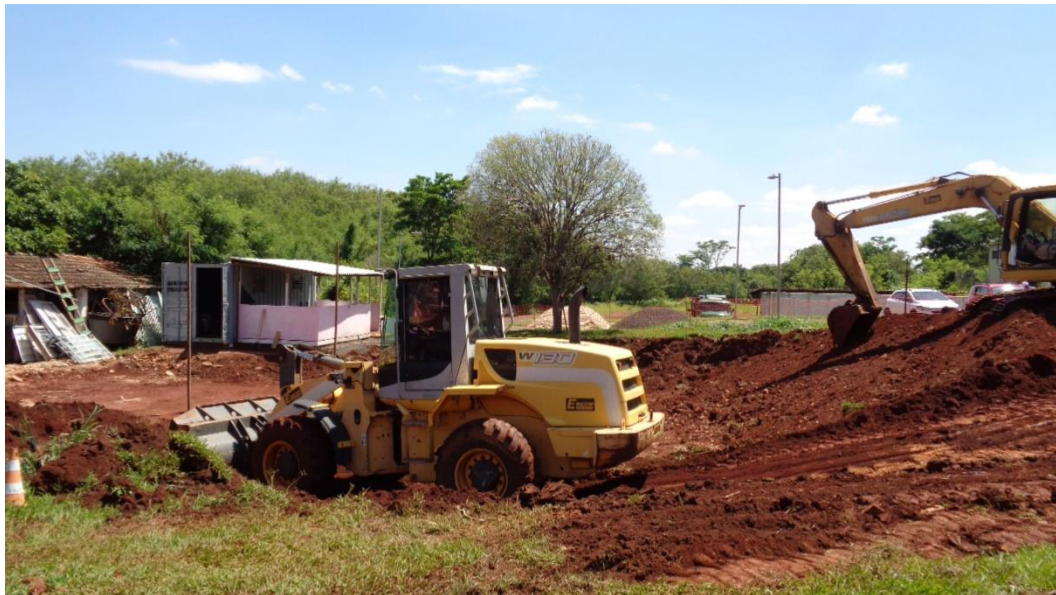
Figura 30. Detalhes da construção do prédio de pesquisa do CENA/USP
