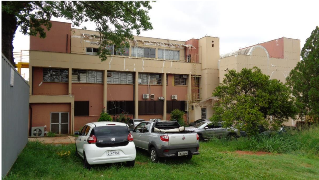
Figura 32. Detalhes do prédio da Química Analítica, com inclusão de pintura e troca dos toldos.
