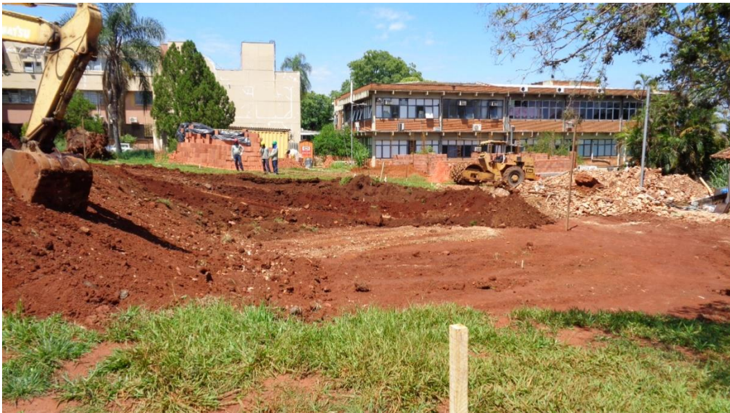
Figura 29. Detalhes do preparo e terraplanagem na construção do prédio de pesquisa do CENA (1ª Etapa).
