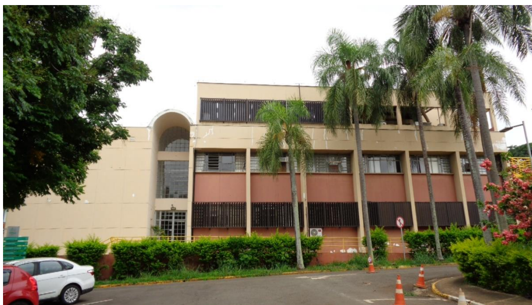
Figura 31. Detalhes da fachada o prédio de Química Analítica do CENA (previsão de pintura externa na 5ª etapa de pequenas obras (licitação prevista para 17/02/2022)
