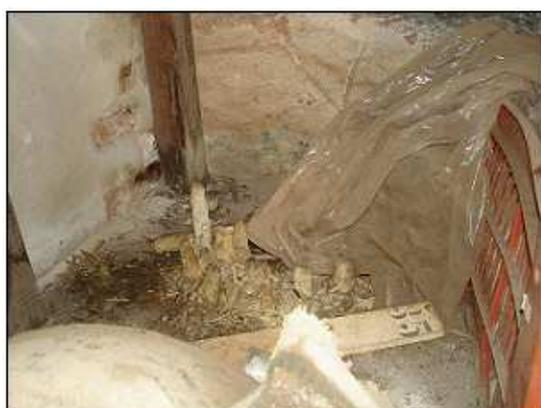
**Figura 7.5** - Presença de fungos indicando umidade
