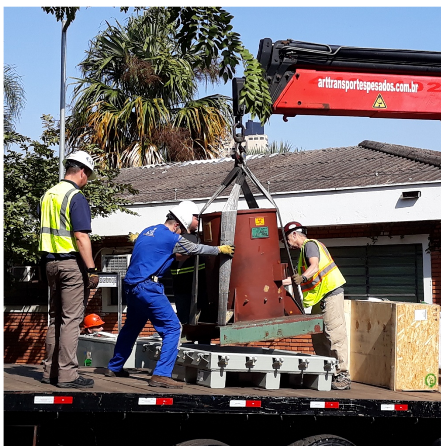
Figura 10. Posicionamento da blindagem de 5,4 t na base da caixa de contenção.
