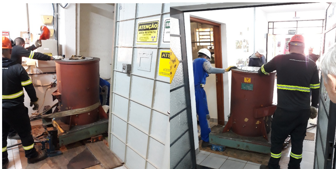
Figura 7. Passagem pela porta blindada da entrada do bunker (à esquerda), e chegada da blindagem do irradiador ao corredor de entrada do LIARE (à direita).
