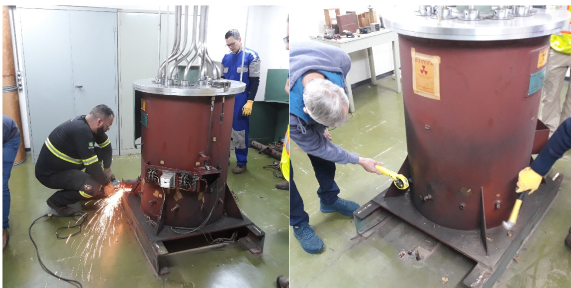
Figura 2. Corte e remoção dos tubos do sistema de injeção de ar na blindagem do irradiador (à esquerda) e fechamento das entradas de ar sob monitoramento da radiação (à direita).
