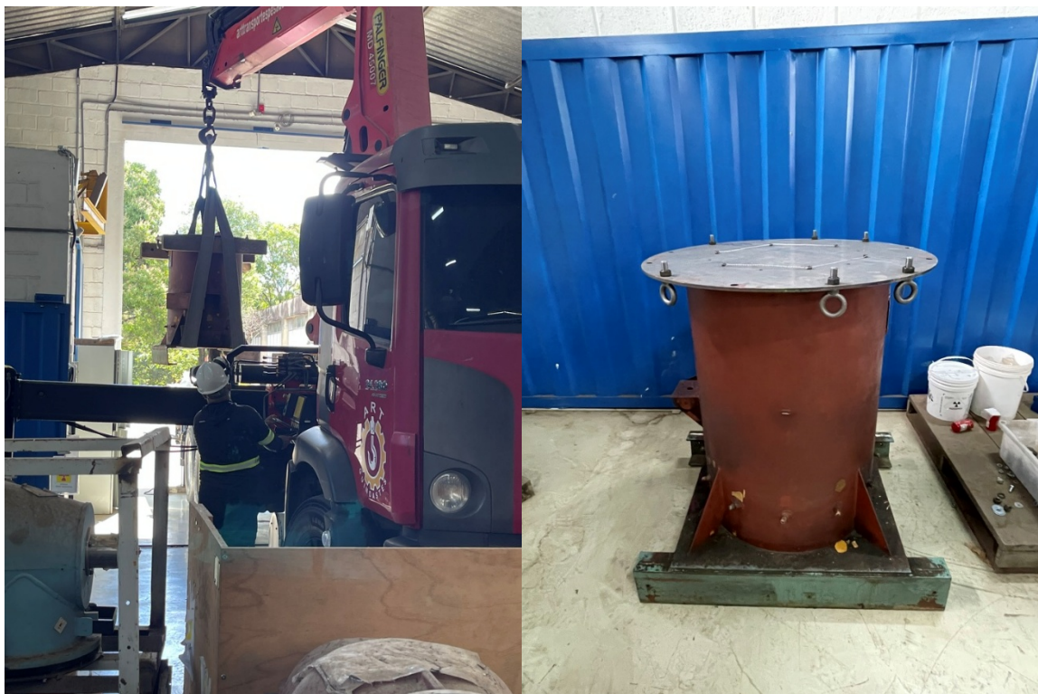
Figura 16. Descarregamento e posicionamento final da blindagem do irradiador no depósito de rejeitos radioativos do CDTN em Belo Horizonte, Minas Gerais.
