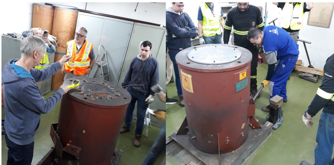
Figura 5. Blindagem do irradiador descoberta e colocação de cabos com pesos metálicos na ponta para evitar a saída das cápsulas de ^{60}\text{Co} (à esquerda), e posicionamento de tartarugas e macaco hidráulico de tipo unha para condução da blindagem pelos corredores do bunker.
