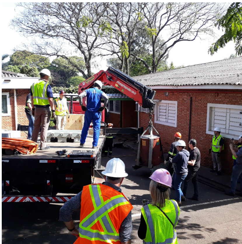
Figura 9. Içamento vertical da blindagem do irradiador.
