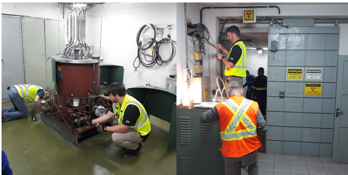
Figura 1. Vistoria e desacoplamento dos painéis do irradiador Gammabeam-650 (à esquerda), e remoção do sistema de cabos de retorno de emergência das fontes (à direita).
