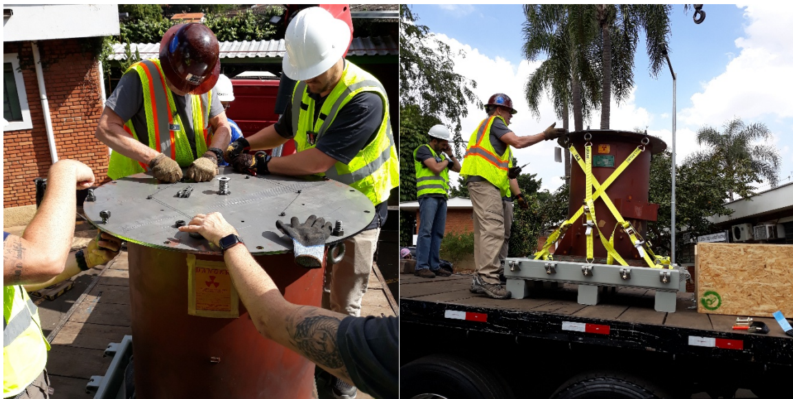
Figura 12. Colocação de arames nos parafusos para selamento da tampa (à esquerda), e fixação da blindagem com cintas catracas (à direita) na base da caixa de contenção.
