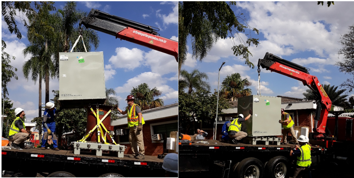
Figura 13. Içamento e posicionamento da tampa da caixa de contenção da blindagem do irradiador.
