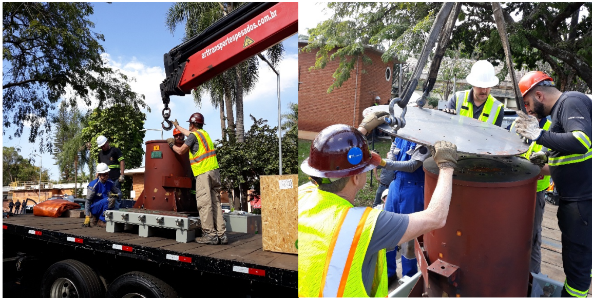
Figura 11. Posicionamento final da blindagem (à esquerda), e colocação da tampa maior de aço carbono para selamento da blindagem do irradiador (à direita).
