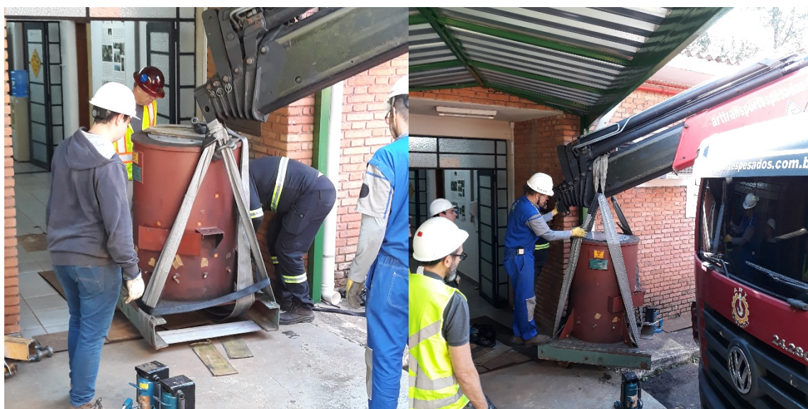
Figura 8. Colocação das cintas de amarração (à esquerda) e início do içamento da blindagem do irradiador (à direita).
