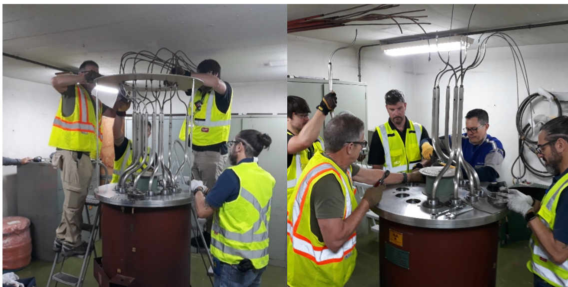
Figura 3. Desmontagem do anel superior de suporte e dos tubos de exposição das fontes do irradiador.
