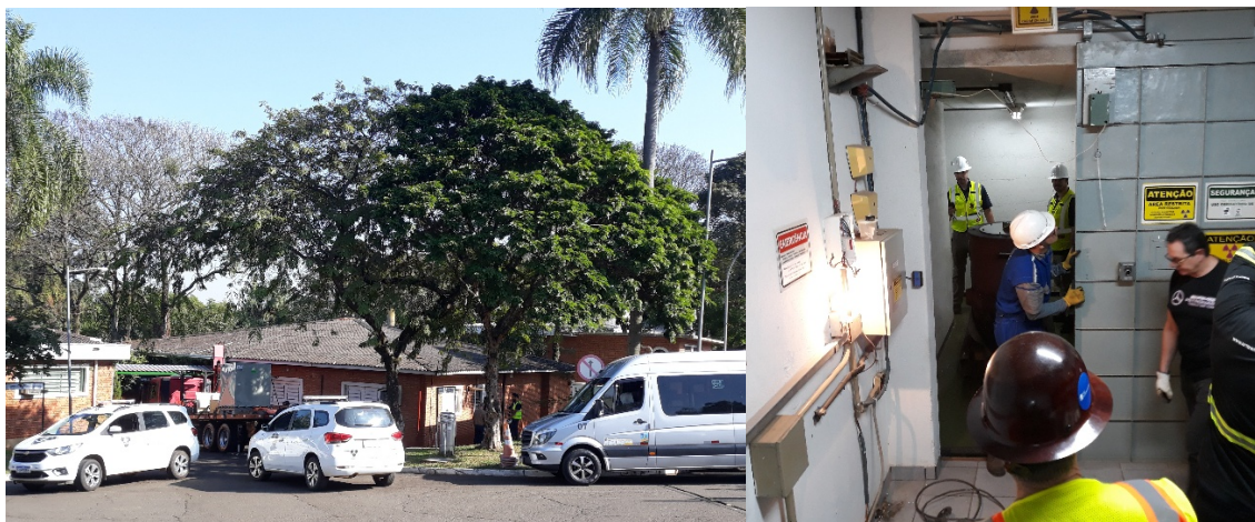
Figura 6. Guindauto e viaturas da guarda universitária em frente ao LIARE (à esquerda) e movimentação da blindagem do irradiador pelos corredores do labirinto até a entrada do bunker (à direita).
